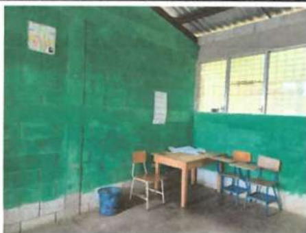
Foto 3: Preparación de la superficie y aplicación de pintura a dos manos, en paredes interiores y exteriores del establecimiento.
