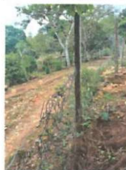
Foto 4: Sustrucción malla de acero galvanizado en perímetro del establecimiento, con instalación fija y tensa, anclajes metalicos en intervalos regulares.
